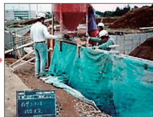
コンクリート充填
